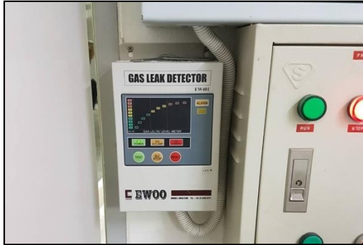
ภาพที่ 2-12 เครื่องส่งสัญญาณเสียงเมื่อก๊าซรั่ว
