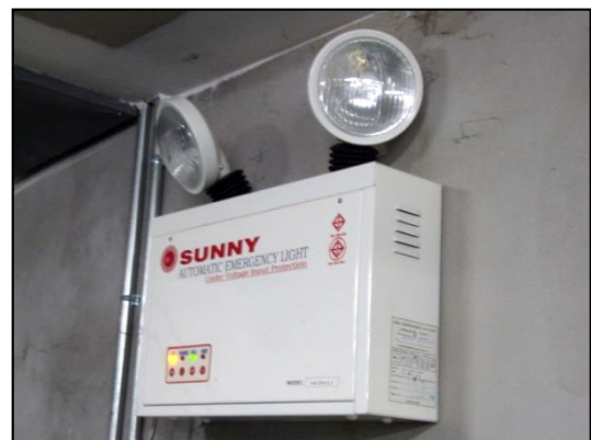
ภาพที่ 1-24 ไฟส่องสว่างฉุกเฉิน
