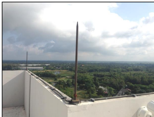
ภาพที่ 1-13 เสาหล่อฟ้า
