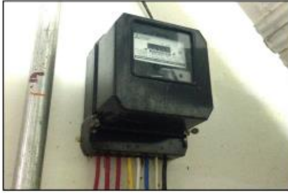
ภาพที่ 3-1 การติดตั้งเครื่องวัดปริมาณการใช้ไฟฟ้าแยกเฉพาะระบบบำบัด
